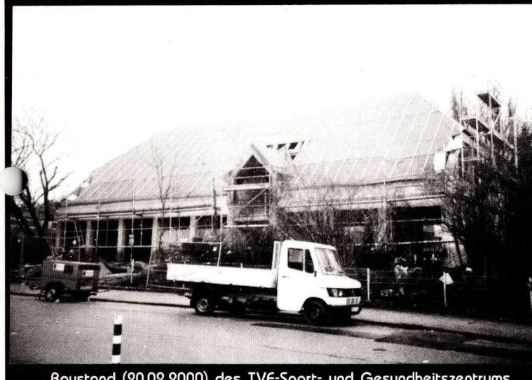
Baustand (20.02.2000) des TVE-Sport- und Gesundheitszentrums
